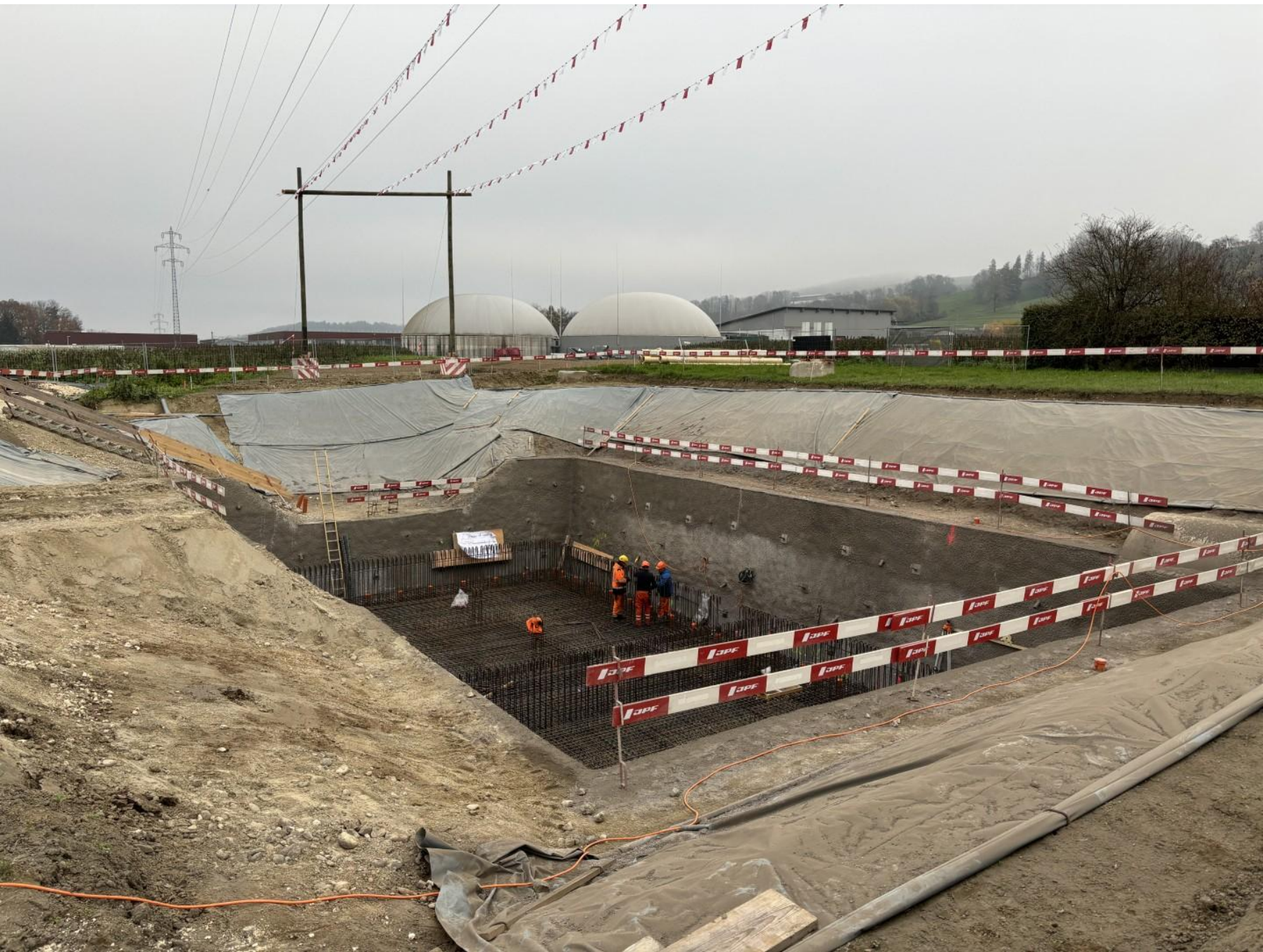
Terrassement STAP de Treize-Cantons
